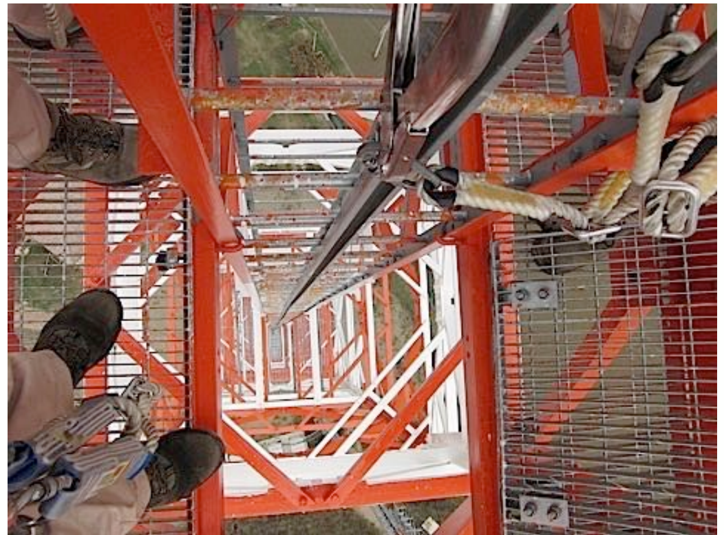
Assistenza al Collaudo: verifica corretto montaggio torre autoportante H=130 m
