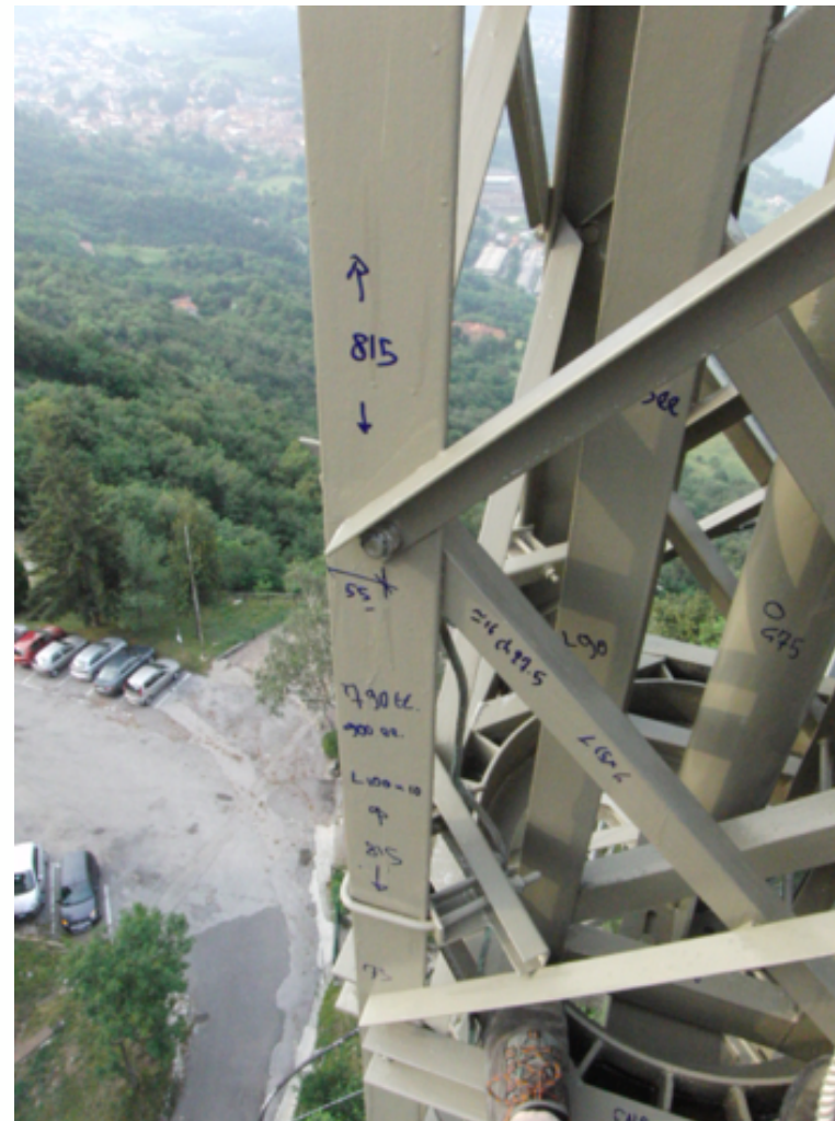
Rilievi in quota di struttura per telecomunicazioni per determinazione geometria, corretto montaggio, carichi al vento
