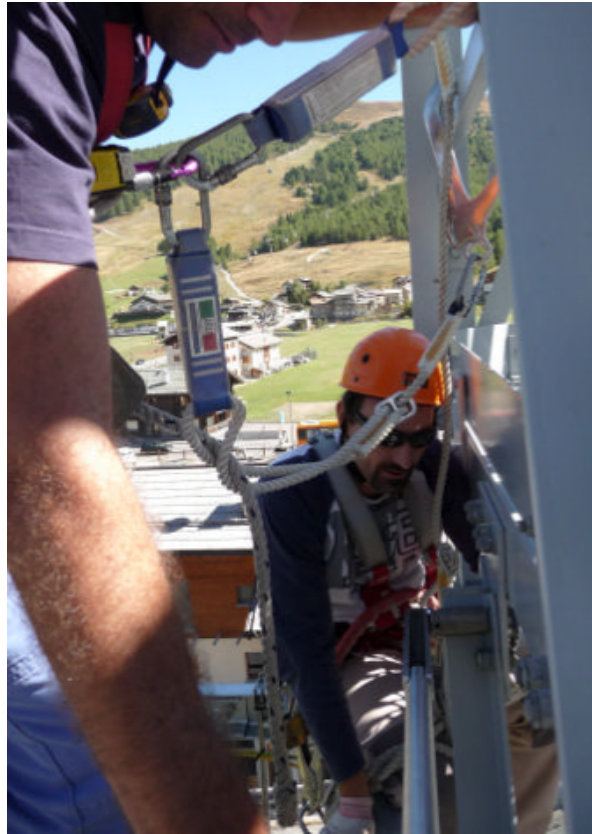
Controllo in quota del serraggio bulloneria mediante chiave dinamometrica
