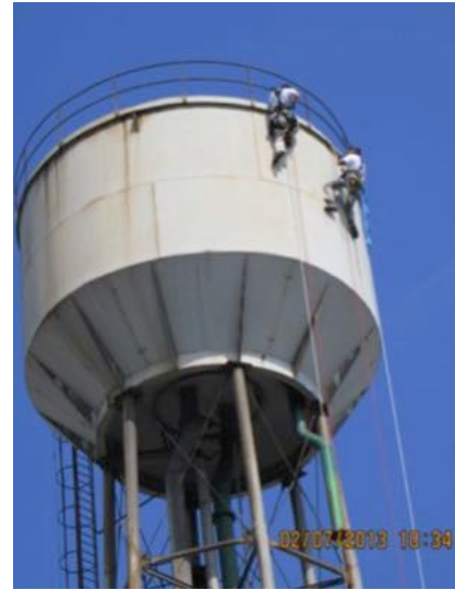
Determinazione spessore lamiera in quota
