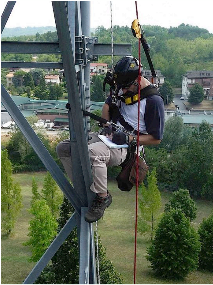
Rilievi in quota in sospensione su fune: presa dei dati geometrici e di carico struttura
