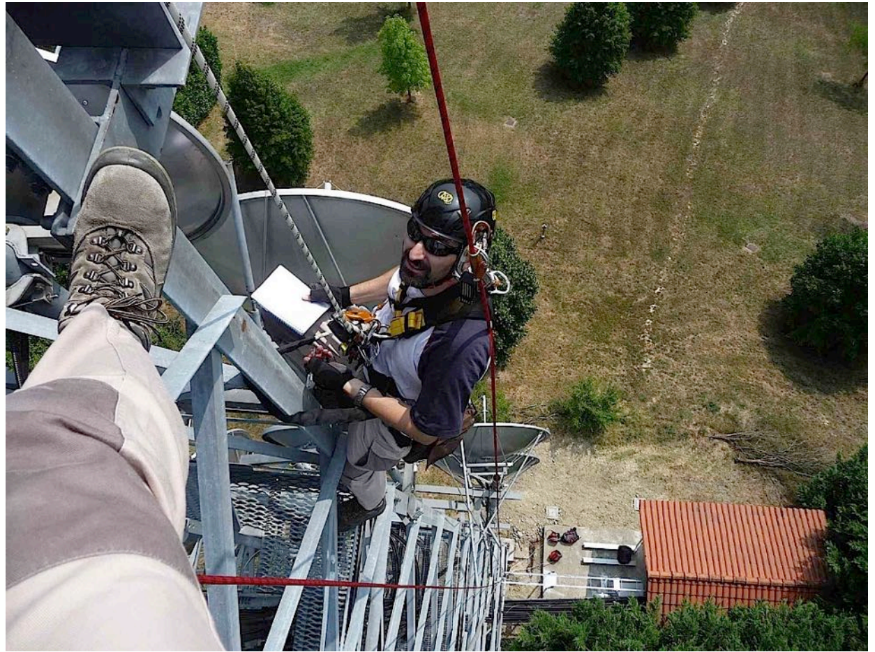
Rilievi in quota in sospensione su fune: presa dei dati geometrici e di carico struttura
