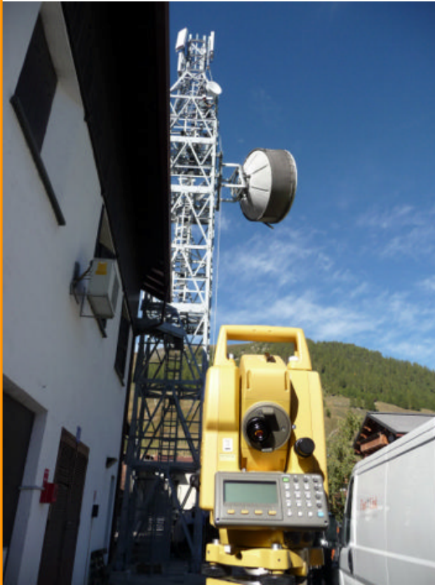
Verifica verticalità tramite strumento topografico
