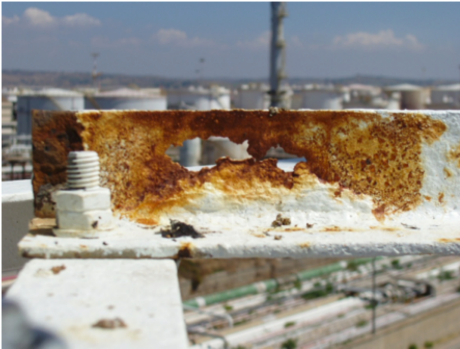
Verifica dello stato di conservazione / manutenzione di strutture in ambiente aggressivo (impianto petrolchimico lungo la linea di costa)
