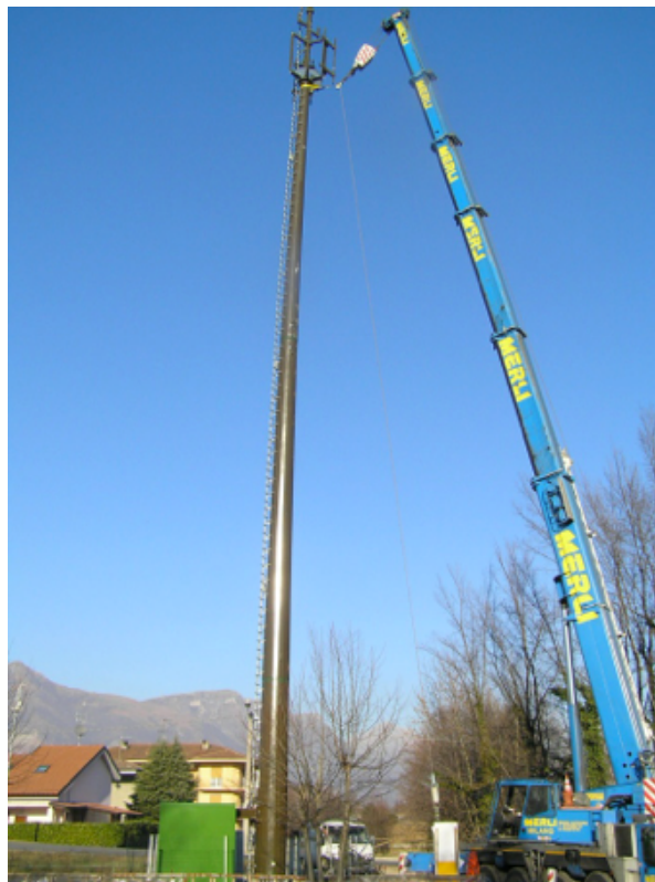
Assistenza al collaudo statico di strutture: prova di carico
