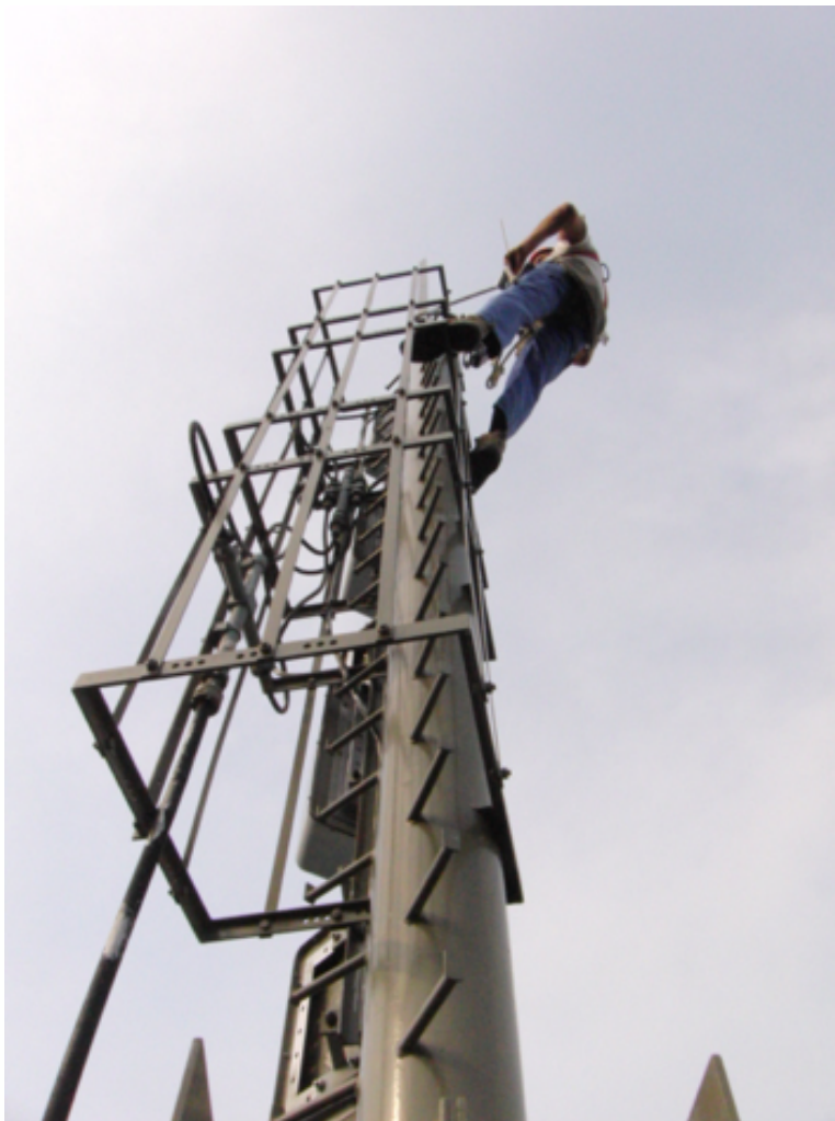
Rilievi in quota di struttura per telecomunicazioni per determinazione geometria, corretto montaggio, carichi al vento
