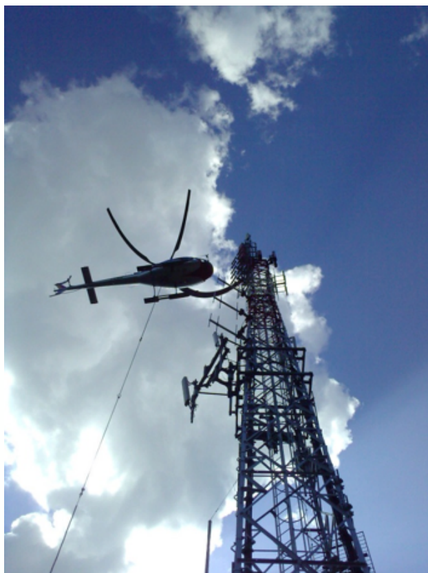
Direzione Lavori di cantieri in condizioni disagiate: esecuzione di rinforzo di fondazione con getti o montaggi tramite elicottero
